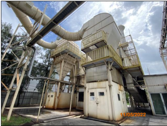
ภาพที่ 2.2-1 Cyclone และ Bag House Filter เตาหลอมเหล็ก
