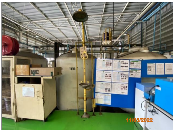
ภาพที่ 2.2-38 อุปกรณ์และแผนผังตำแหน่งติดตั้งอุปกรณ์ล้างตาและฝักบัวฉุกเฉิน
