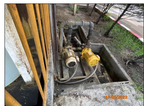
ปั๊มสูบน้ำสารเคมีและบ่อรวบรวม (Sump Pit)
